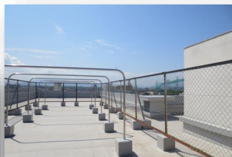
↑屋上(物干し場)
